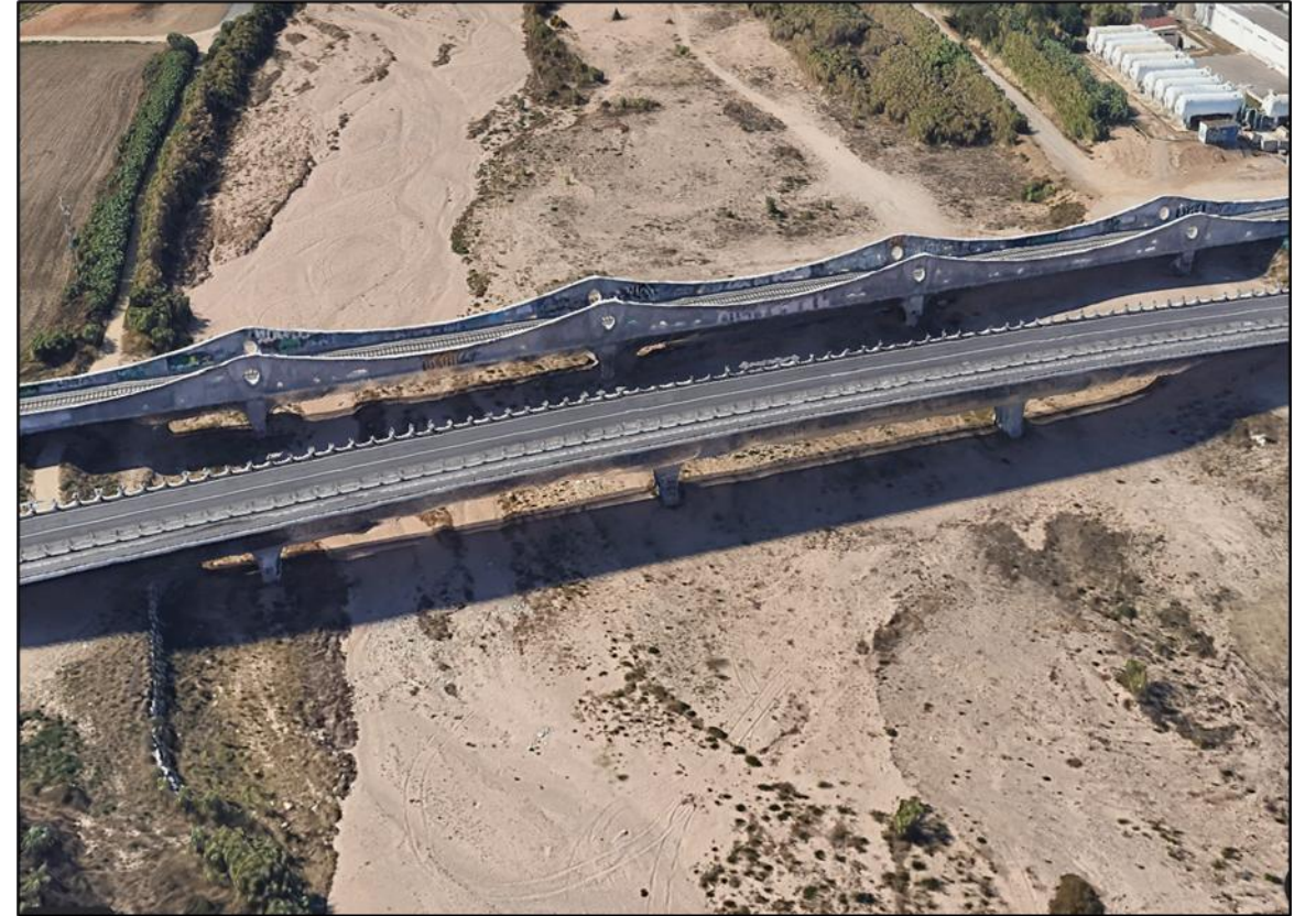
Adaptació dels ponts sobre la Tordera després del temporal Glòria
